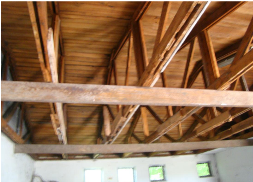
Fot. 2. Widok konstrukcji dachu – boks nr 1 z brama przesuwana.
