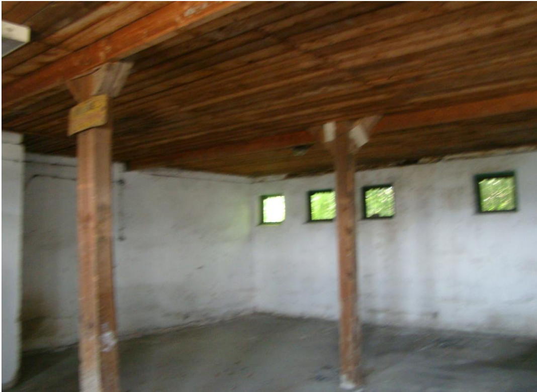
Fot. 3. Widok konstrukcji dachu – boks nr 3 z podbitką drewnianą.
