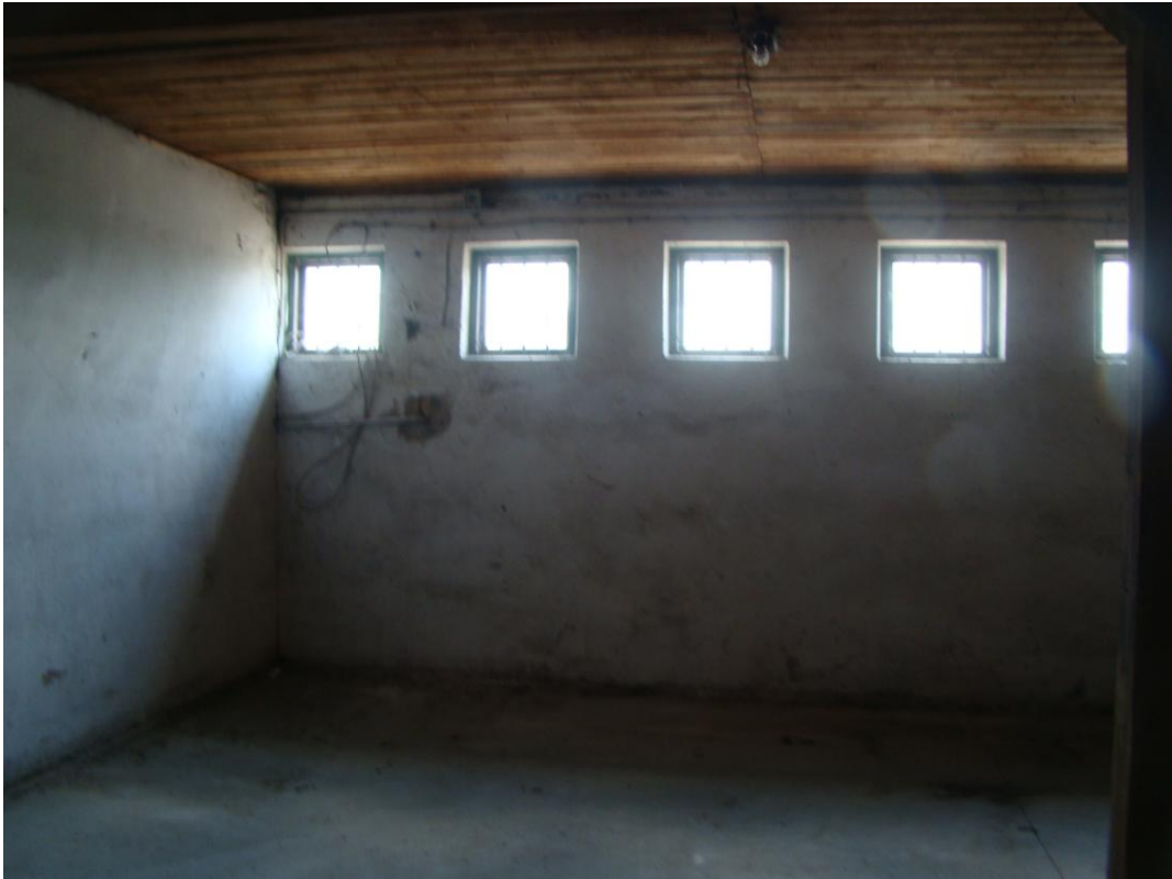
Fot. 6 . Widok ścian , posadzki oraz części konstrukcji dachu od wewnątrz budynku boks nr 3.
