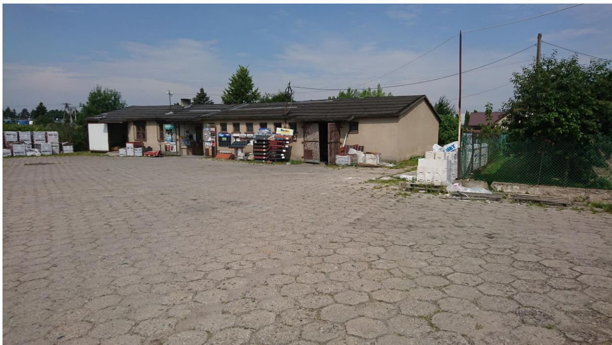
Ryc. 6. Magazyn do modernizacji
